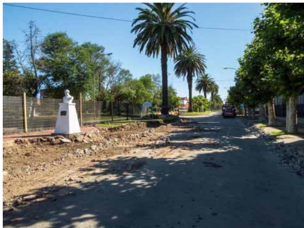
La avenida Belgrano, en plena construcción del Centro Cívico.
